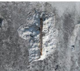
外壁材の剥落
