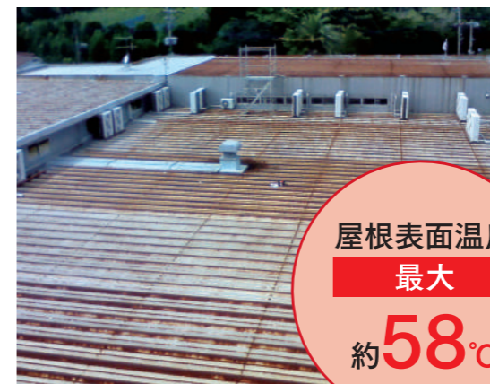
■ 施工前 (8/12 14:00頃撮影)
