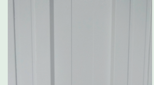
施工後1年4カ月経過後もカビが発生していない
