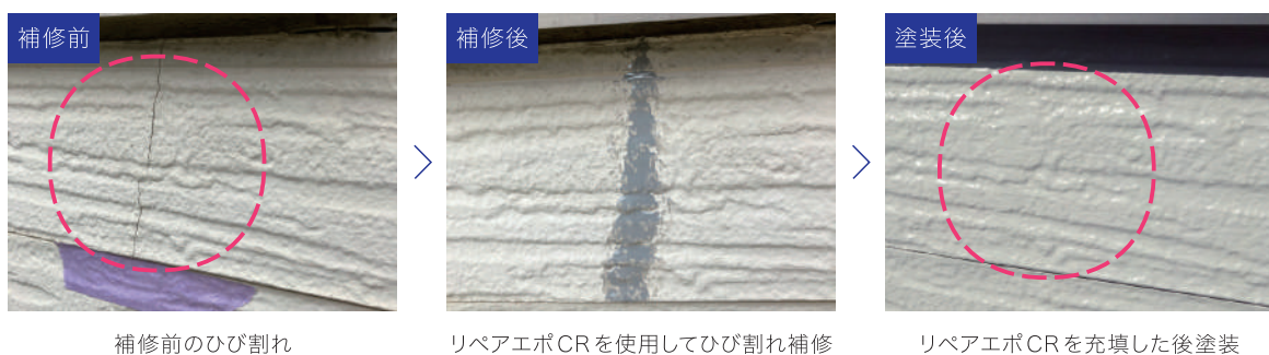
補修前のひび割れ リペアエポCRを使用してひび割れ補修 リペアエポCRを充填した後塗装
