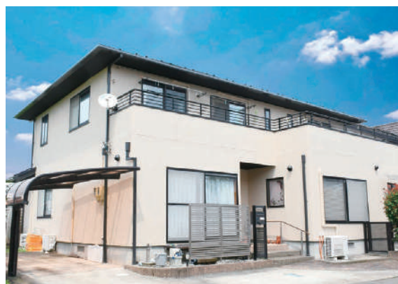
色：メリーノ 施工時期：2017年12月
